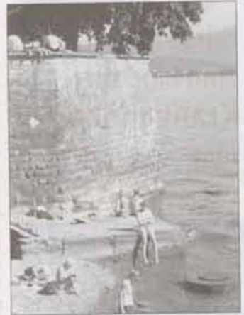
Bedingt durch die Insellage hat Lindau viel hart verbautes Ufer, wie hier auf der hinteren Insel.
