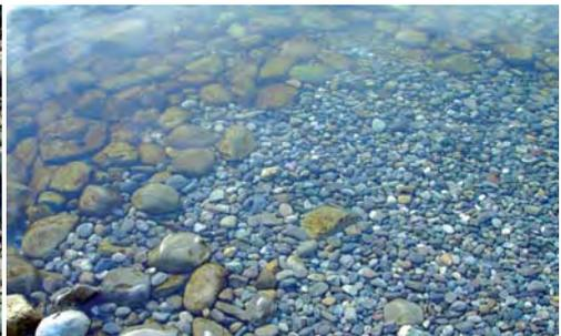
Harter Übergang zwischen Wackeln im Böschungsfuß und monotonem, feinkörnigem Deckmaterial (Mittelkies).
