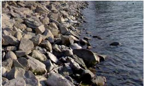
Naturferne, gebrochene Blöcke einer Molensicherung. Fremdmaterial; Fehlender Übergang zu Eulitoralstrukturen.
