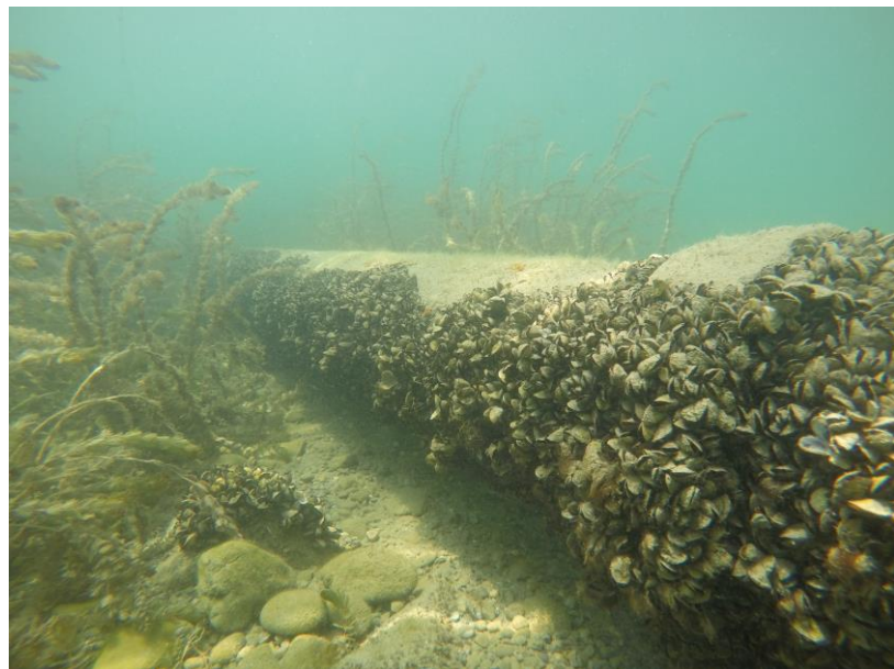
Die Quagga-Muschel bedroht im Bodensee nicht nur das ökologische Gleichgewicht, sondern lagert sich auch auf Infrastrukturbauten ab.
